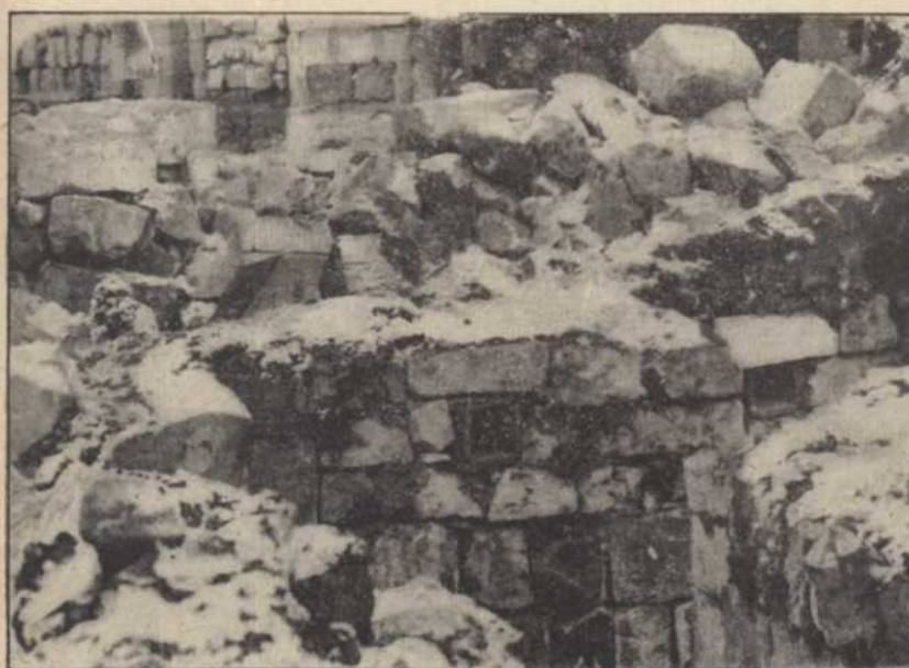
Le siège d'Ain-Tab. — Tranchée couverte de 2 e ligne turque (Vue prise après la destruction partielle de l'ouvrage).
